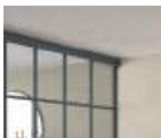
— pose au plafond
