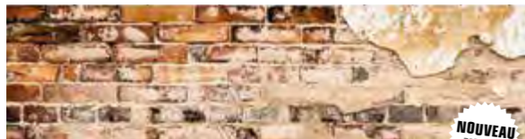
323 mur de briques 323 bakstenen muur
